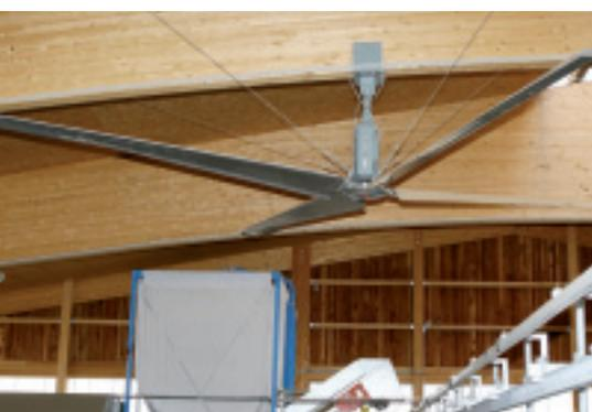
Die Leimbinder sind bei einer Spannweite von 25 m und einem Achsenabstand von 10 m am Giebel 2,6 m stark. Dafür sind nur neun Säulen im Gebäude. Die Ventilatoren laufen temperaturgesteuert.
